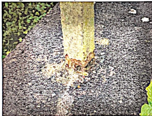
GELÄNDERPFOSTEN DURCHGEROSTET
